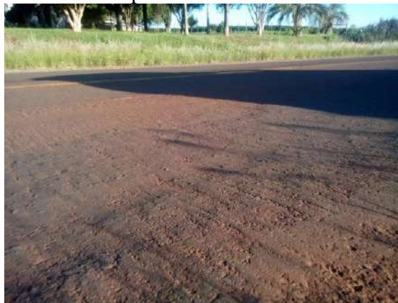
Figura 3 - Corrugação no trecho RS 305 entre Tuparendi e Tucunduva/RS
