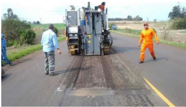
Imagem 1. Fresagem do pavimento
