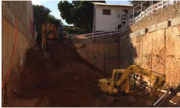
Figura 7. Escavação em andamento
