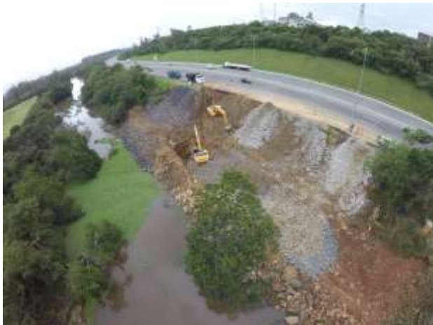
Figura 10. Durante a realização da obra emergencial para estabilização do talude.
