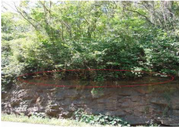
Figura 6. Talude no km 194 + 400
