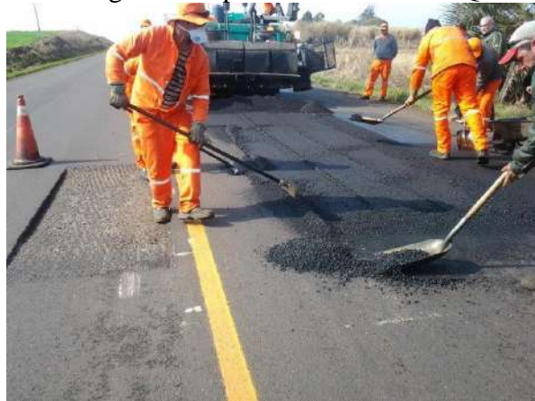
Imagem 2. Espalhamento do CBUQ
