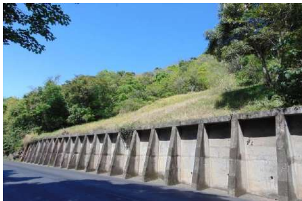
Figura 2. Contenção no km 196 + 300
