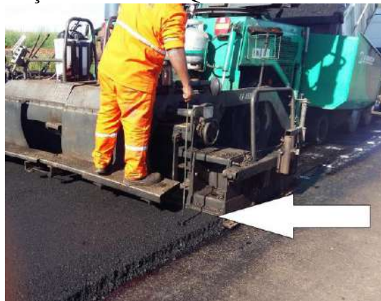
Imagem 5. Verificação da espessura de lançamento do CBUQ
