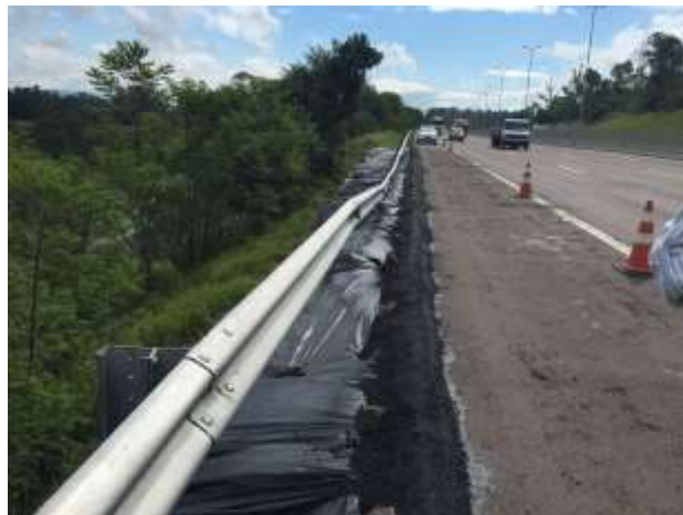
Figura 8. Vista da Rodovia no km 76 da BR-290/RS – Execução de sarjeta com material asfáltico
