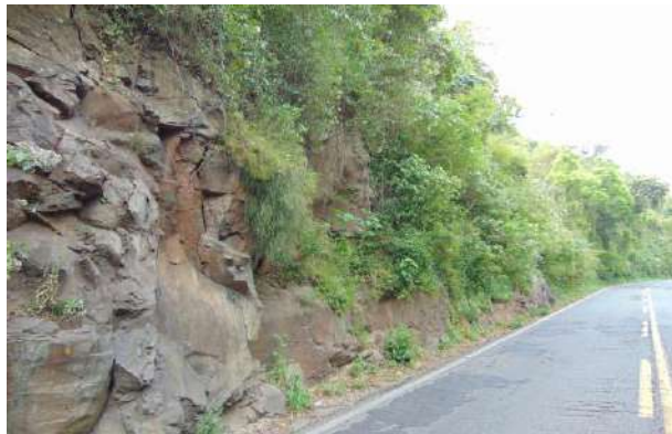
Figura 14. Talude no km 192 + 800
