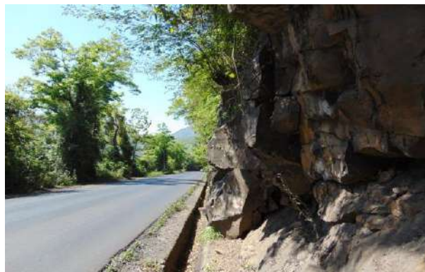
Figura 4. Talude no km 194 + 800
