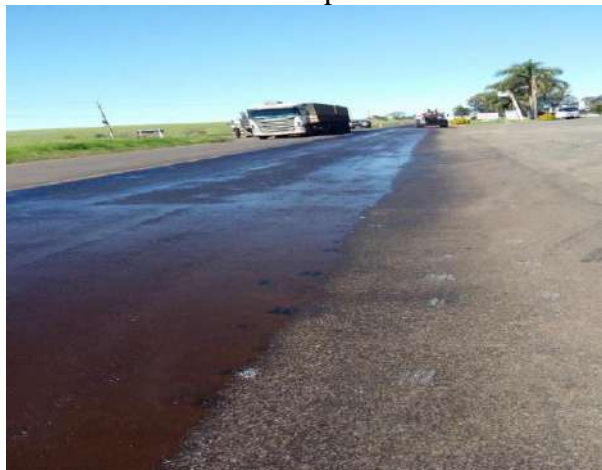
Imagem 4. Pintura de ligação para execução da capa
