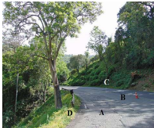
Figura 8. Talude no km 188 + 400
