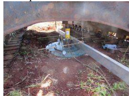
Figura 2: Ensaio de placa Costa do Sol
