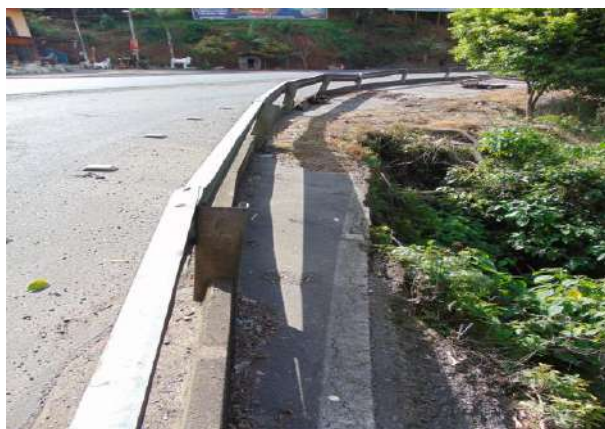
Figura 10. Talude no km 188 + 900
