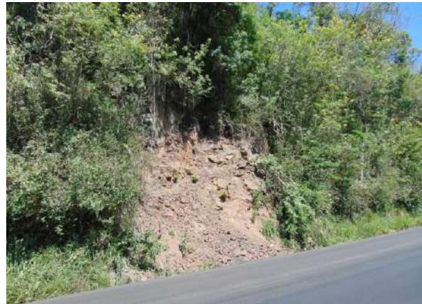
Figura 16. Talude no km 196
