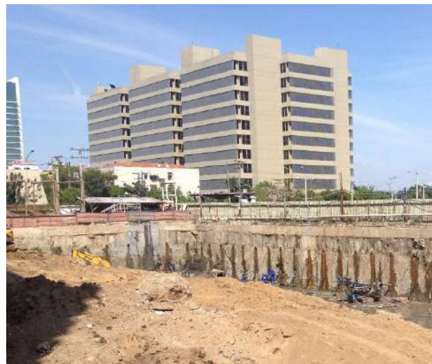
Figura 2. Início da escavação
