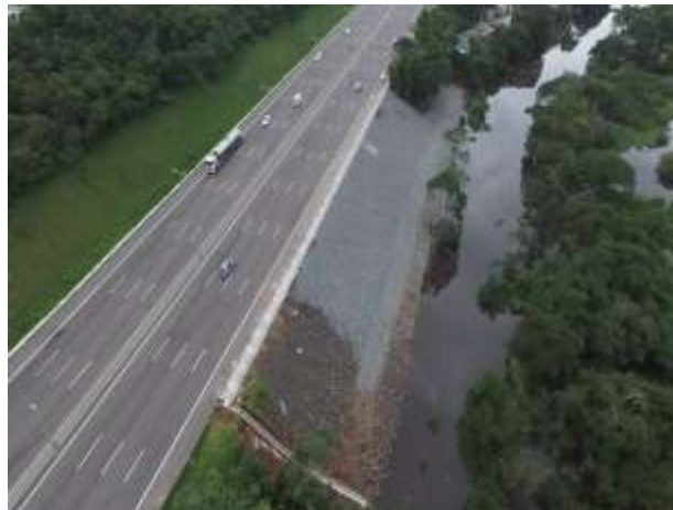
Figura 12. Obra emergencial da recuperação talude concluída
