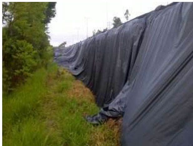
Figura 9. Vista do talude no km 76 da BR-290/RS – Proteção com lonas plásticas (impermeabilização)
