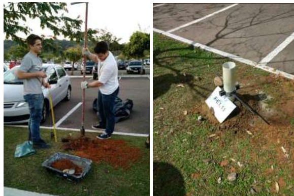
Figura 5. Execução das sondagens e colocação do tubo de PVC diâmetro 10 cm para ensaios
