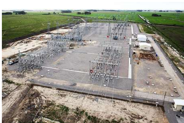
Figura 4. Obra da Subestação Santa Vitória do Palmar A,B - 500/138 KV - Eletrosul (SCHREIBER ENGENHARIA, 2016)
