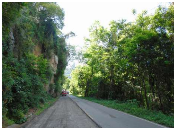
Figura 12. Talude no km 189 + 500
